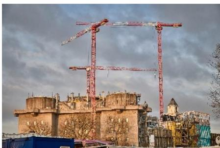
Die spitzenlose Konstruktion der Obendreher ermöglicht Ausleger-Abstände von ca. 10 Metern zueinander und damit ein niedriges und effizientes Krankonzept.
