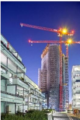
Der WOLFF 7534.16 und der WOLFF 6015.8 gehören zur *clear*-Reihe und sorgen für eine effiziente Logistik auf dem beengten Baufeld.
