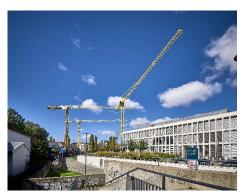
1- bis 5-Zimmer-Bau von Wohnungen im isarnahen Münchner Stadtteil Au. Auf dem beengten Bauareal am Rande eines Wohnviertels ist ein WOLFF 7532 mit 12 Tonnen-Winde und 4 Tonnen Spitzentragfähigkeit bei 70 Metern Auslegerlänge im Einsatz. sowie zwei spitzenlose Obendreher der Typen WOLFF
