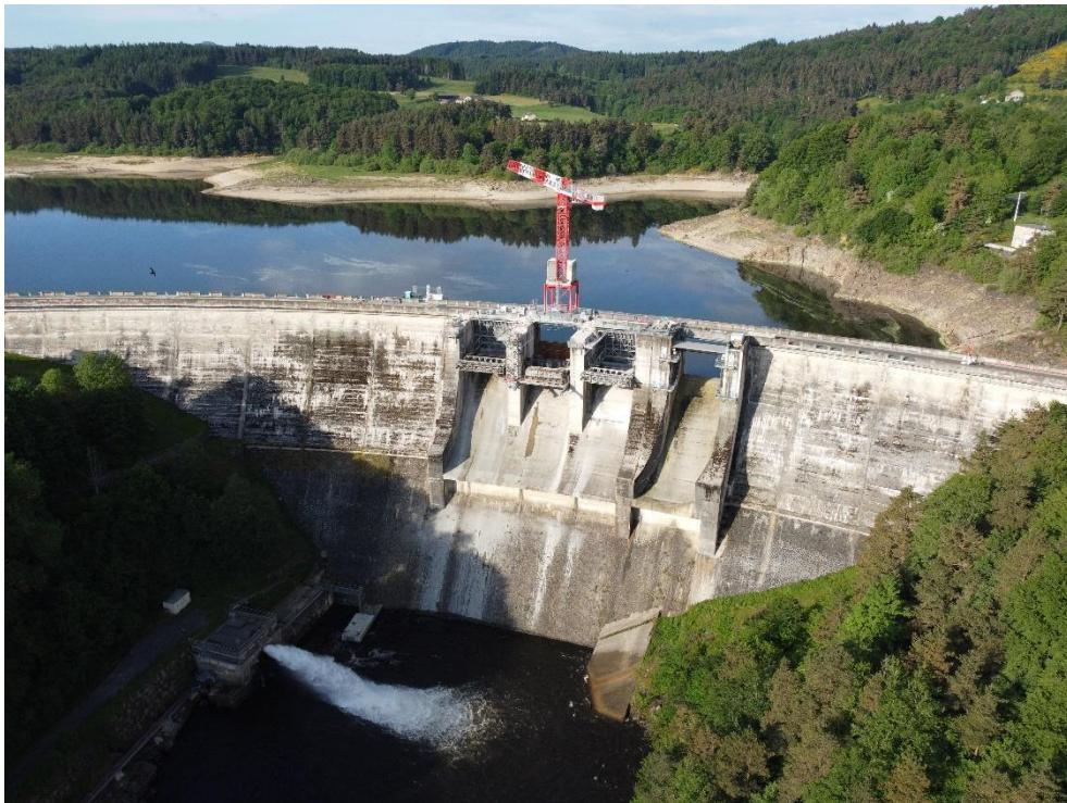
Der WOLFF 7534.16 Clear mit einer Hakenhöhe von 20,4 Metern, einer Auslegerlänge von 40,0 Metern und einer Tragfähigkeit von 16,0 Tonnen übernimmt den Austausch der Hochwasserklappen am Staudamm Barrage de Lavalette im Südosten Frankreichs.
