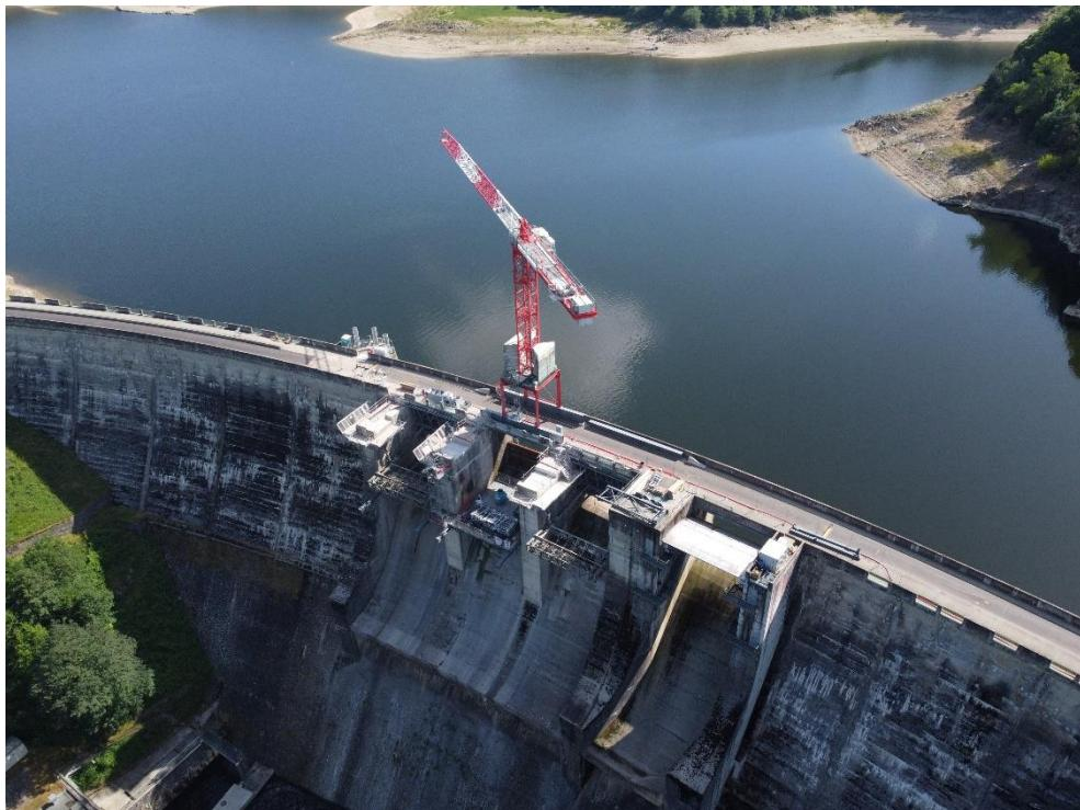
Une WOLFF sait aussi s'adapter aux contraintes des projets : pour la rénovation du barrage de Lavalette Wolffkran a fourni un pack-age complet comprenant la grue, la solution sur portique, le ser-vice, la maintenance et l'exploitation de la grue.
