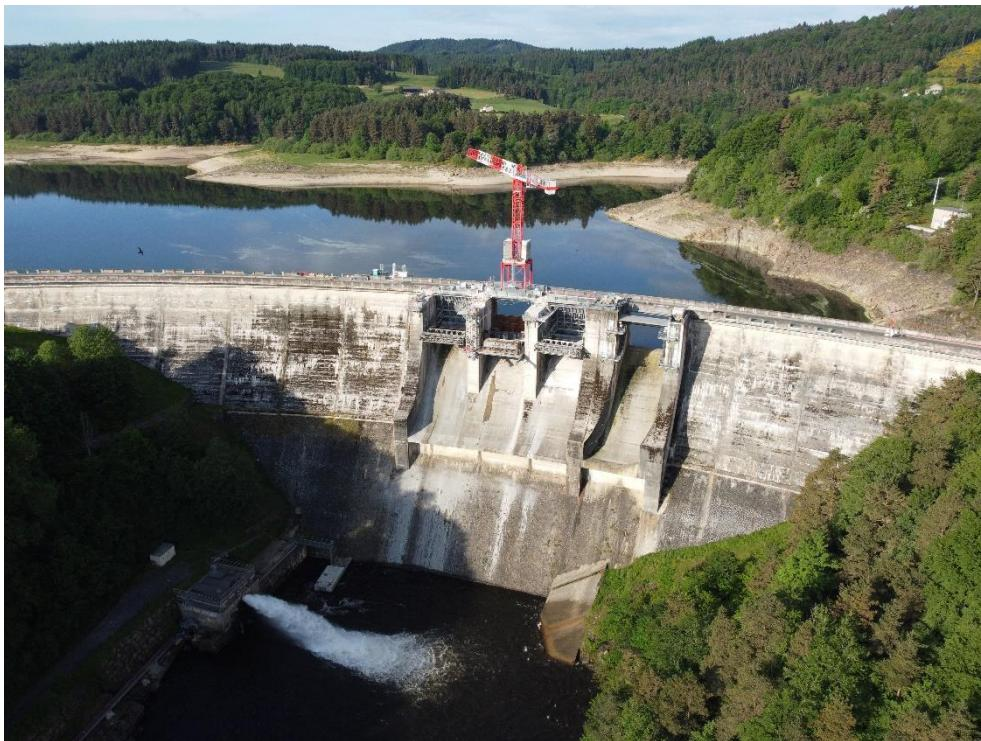
Une grue WOLFF 7534.16 Clear - 20,4 mètres de hauteur sous crochet, 40 mètres de flèche avec une capacité maximale de 16 tonnes, est chargée de l'installation des vannes anti-inondation du barrage de Lavalette, dans le sud-est de la France.
