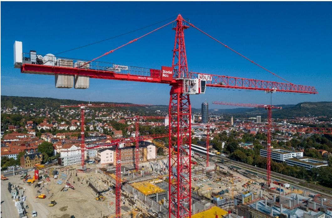
Der WOLFF 6071.20 Cross ist das Kraftpaket des WOLFF-Rudels auf der Zeiss-Baustelle. Er hebt bis zu 22 Tonnen schwere Fertigteile.
